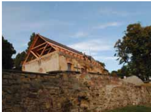
Obnova krovu a střechy kostela v roce 2017
