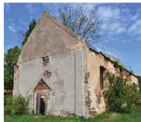
Západní průčelí kostela sv. Jakuba Staršího – stav v roce 2015
